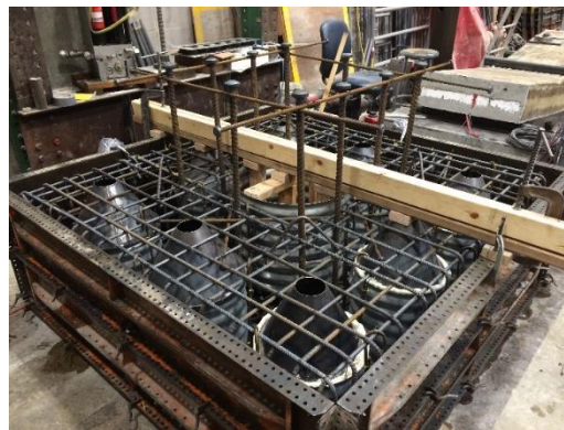
Figure 5.12. Pile cap before concrete pour
